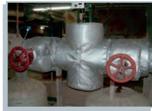
Ilustración 17 Imágenes- aislaciones correctas. Fuente: comeval.es
