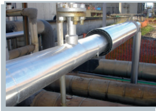
Ilustración 17 Imágenes- aislaciones correctas. Fuente: comeval.es
